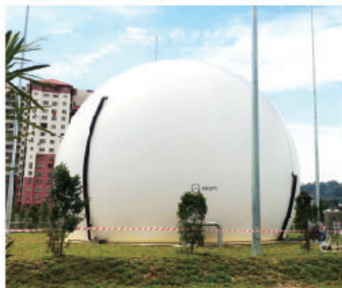
■ 马来西亚Pantai第二污水处理厂项目
